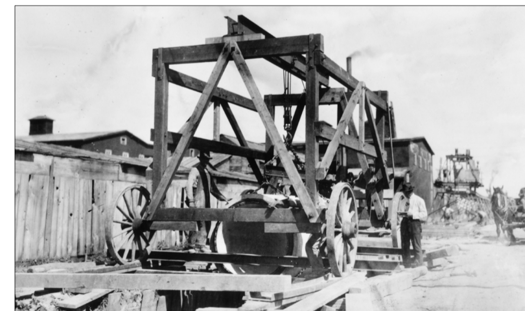
L'aqueduc de la branche 1 fait 18,8 km de long.
