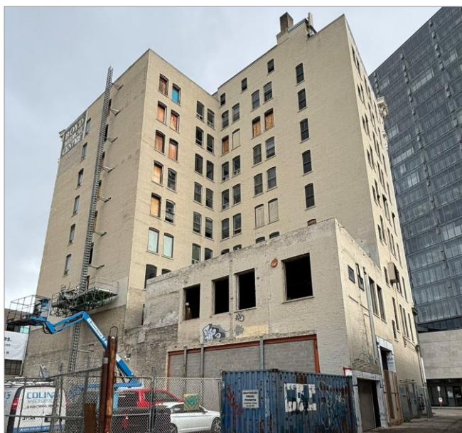
Édifice Boyd, 388, avenue Portage, remplacement de la fenestration à l'arrière, 2025
