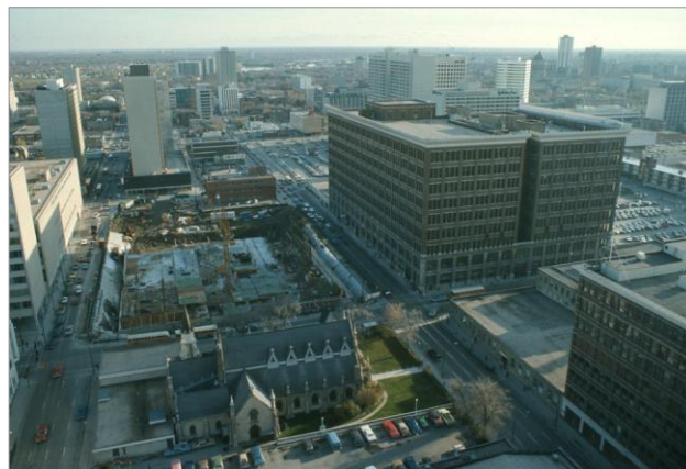
Édifice T. Eaton Company de vente par catalogue, 333, avenue St. Mary, 1975
