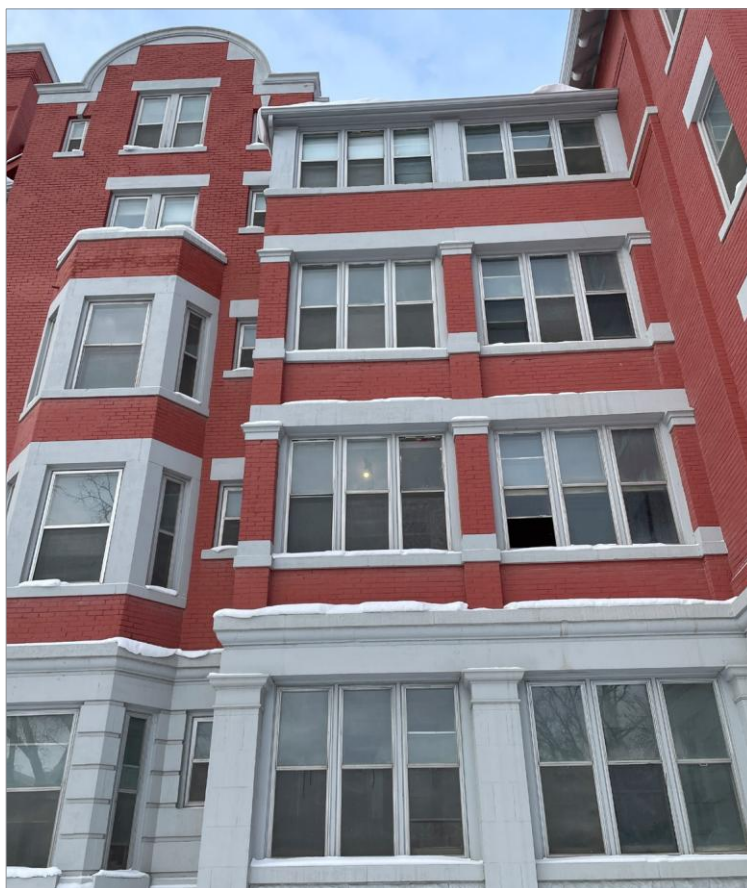
Appartements Roslyn, 40, rue Osborne, fenêtres typiques, 2024
