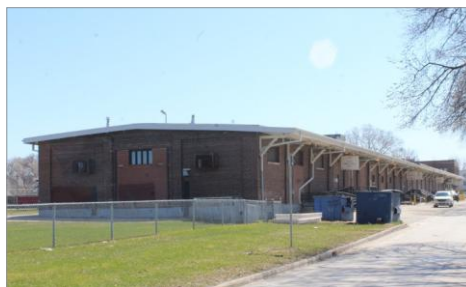
Édifice Midland Railway, 200, rue Isabel, façades arrière et sud, 2020
