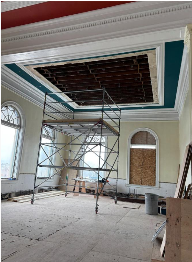
Bibliothèque Carnegie, 380, avenue William, travaux de rénovation en cours, 2026
