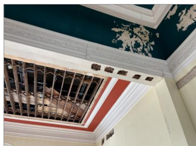
Bibliothèque Carnegie, 380, avenue William, travaux de rénovation en cours, 2026
