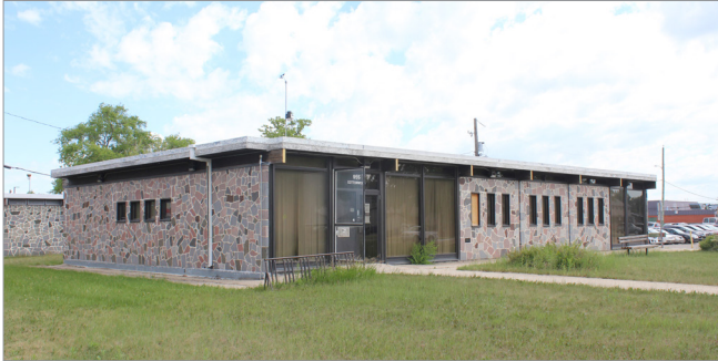
Bibliothèque de Windsor Park, 955, chemin Cottonwood, façades avant et ouest, 2021
