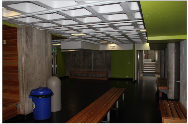
Pavillon Peguis, 2015, rue Main, parc de Kildonan, sous-sol avec plafond en dalles gaufrées d'origine, 2022
