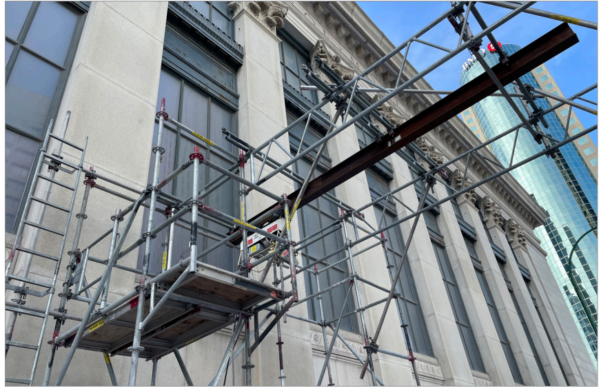
335, rue Main, travaux en cours sur la façade avant, 2024
