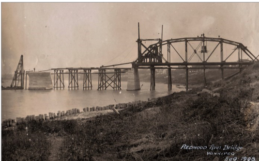
Pont Redwood, travaux de construction de la superstructure, août 1908
