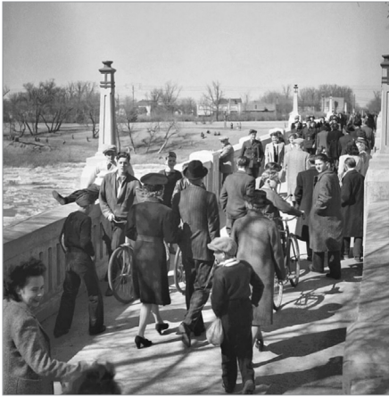
Passerelle du parc Assiniboine, 1944, montrant l'éclairage d'origine
