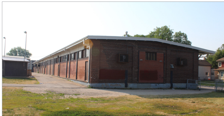
Bâtiment Midland Railway, 200 rue Isabel, façades arrière et nord, 2021
