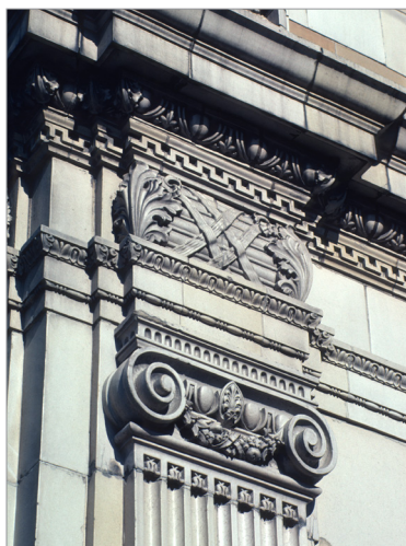
Ornementation en terre cuite du bâtiment Lindsay, 228, avenue Notre-Dame, 1980
