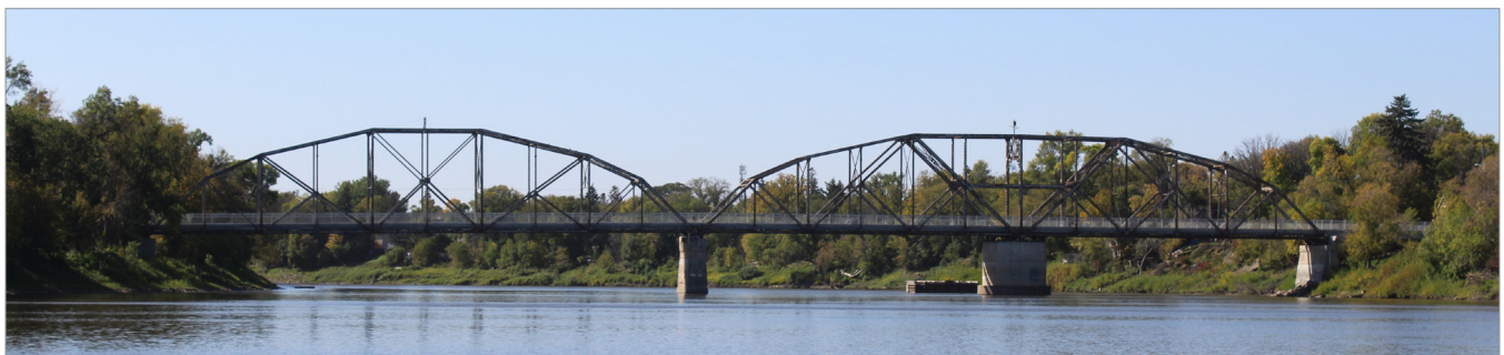
Pont d'Elm Park, côté ouest, 2022
