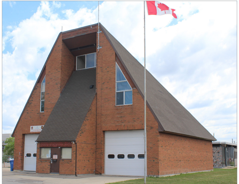
Poste d'incendie n° 4, 1083, promenade Autumnwood, façades avant et sud, 2021
