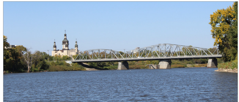
Pont Redwood, côté sud, 2022
