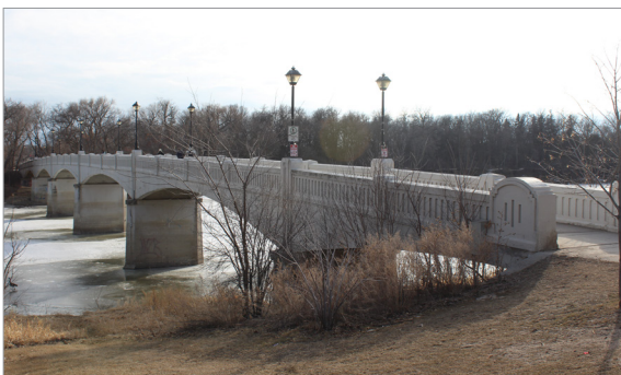
Passerelle du parc Assiniboine, côté est, 2021
