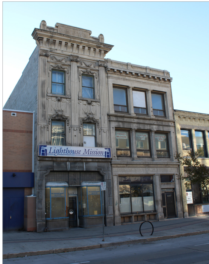
667 et 669, rue Main, façades avant, 2018
