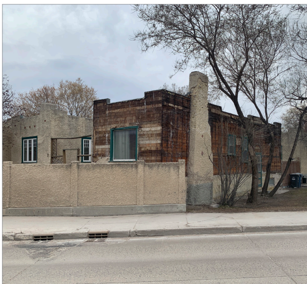
Unité 1, 40, chemin St. Mary's, stuc enlevé, 2024
