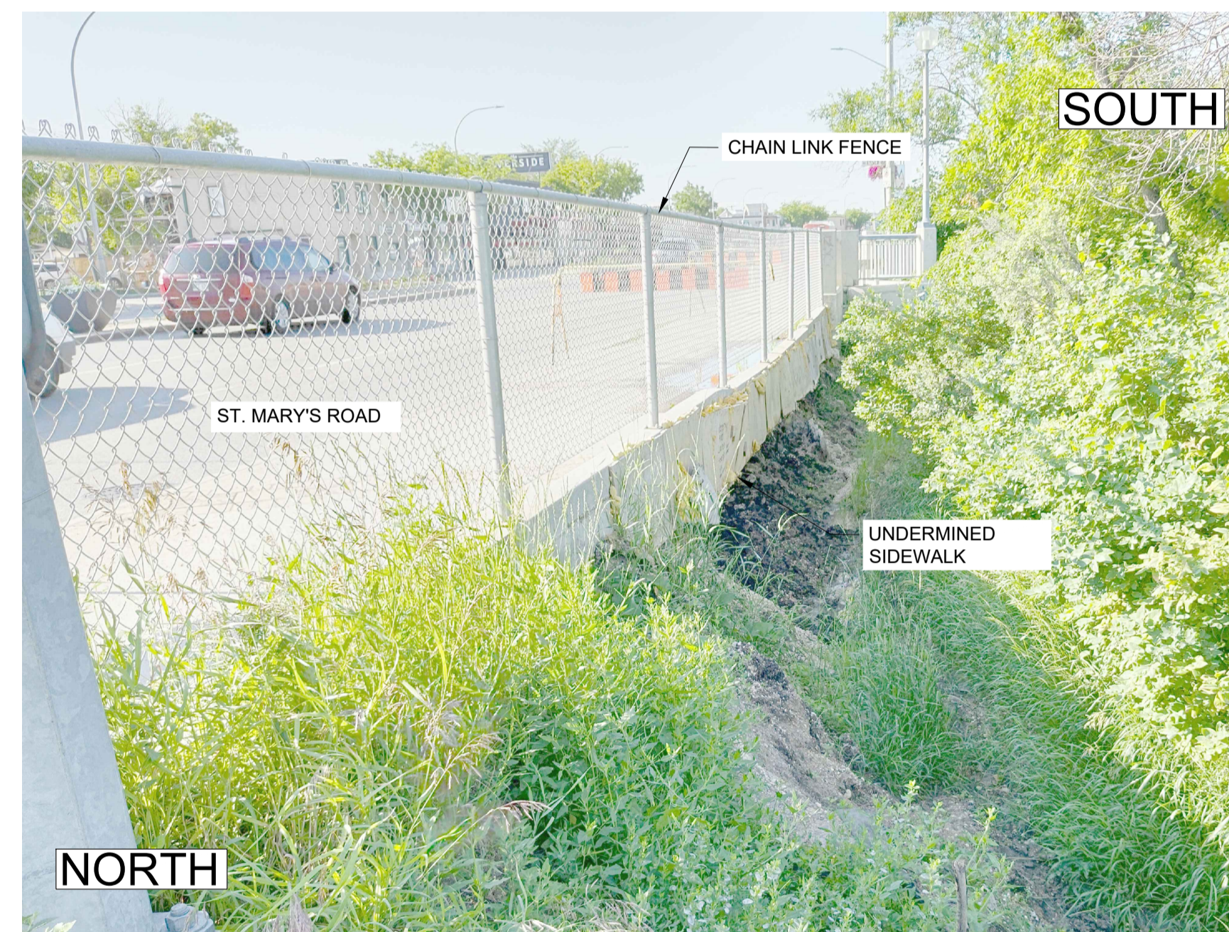
SIDEWALK REPAIR AREA SCALE: N.T.S.
