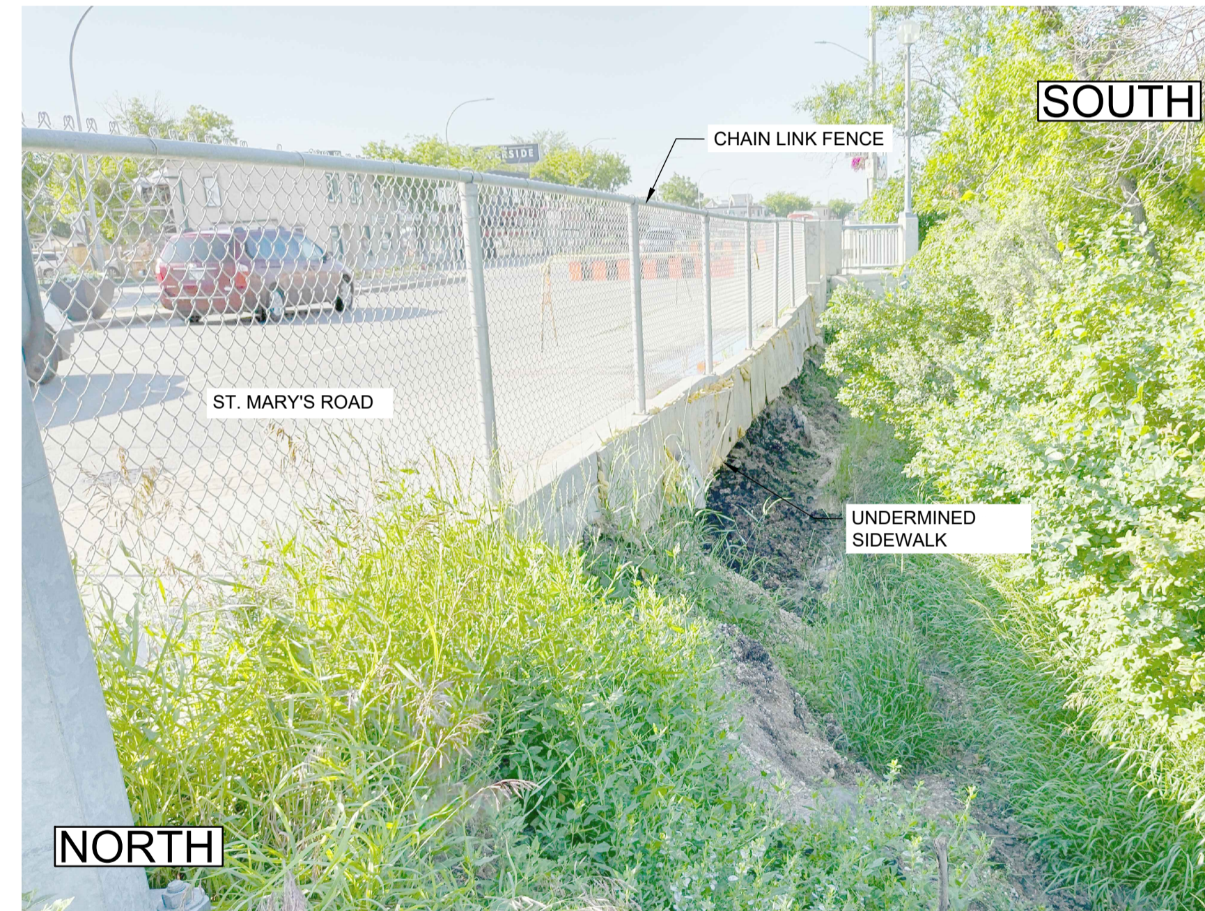
SIDEWALK REPAIR AREA SCALE: N.T.S.
