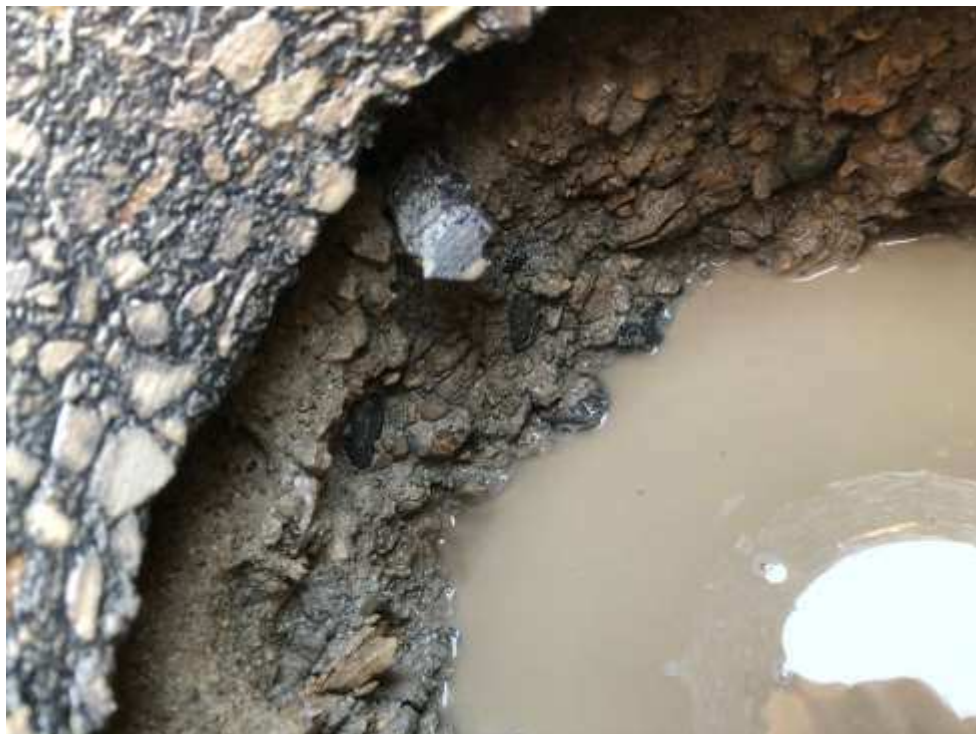
South bound longitudinal joint, Sta. 0+357
