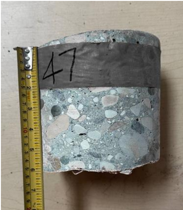
Westbourne Cr, EBL ++ , Core 47 (Concrete Thk 150mm)
