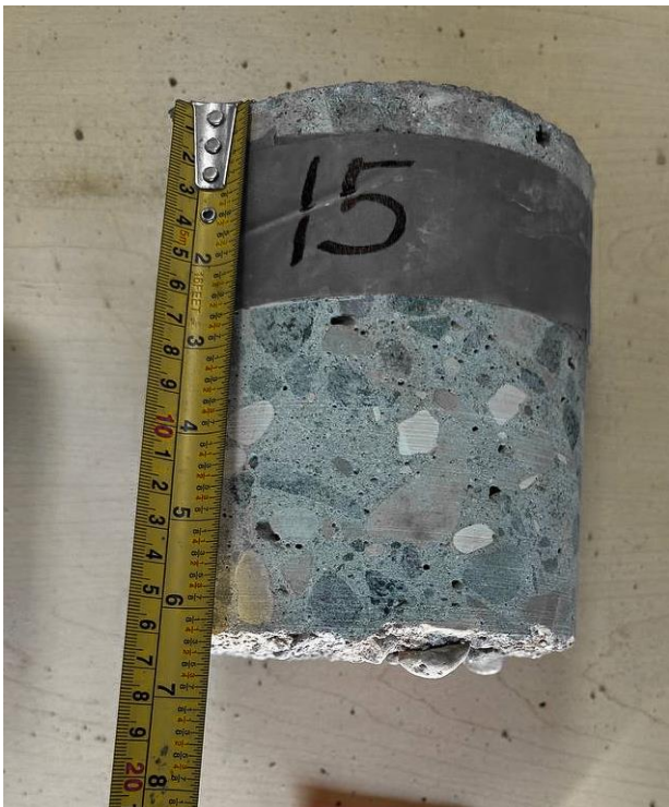
Delorme Bay, NBL ++ , Core 15 (Concrete Thk 160mm)
