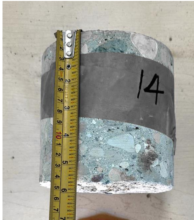
Delorme Bay, WBL ++ , Core 14 (Concrete Thk 142mm)
