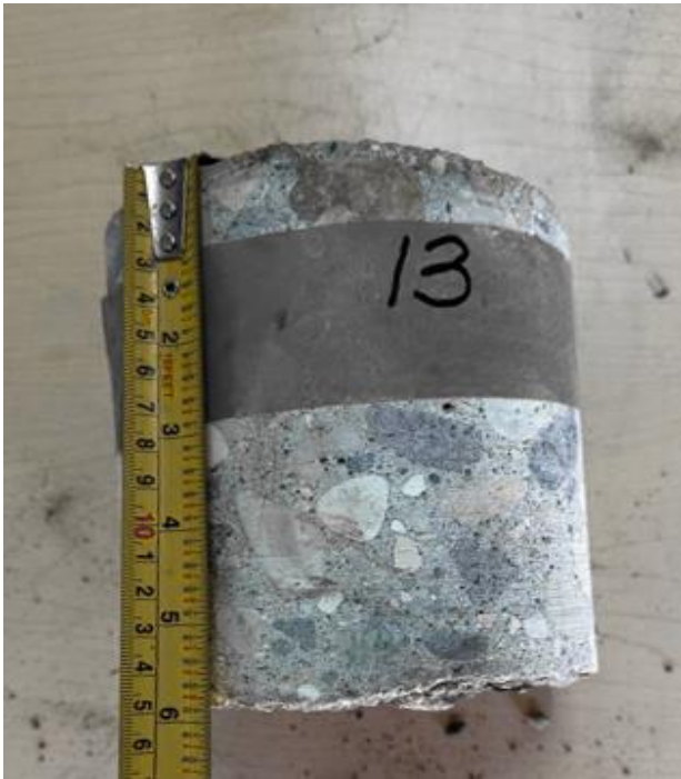
Delorme Bay, SBL ++ , Core 13 (Concrete Thk 143mm)
