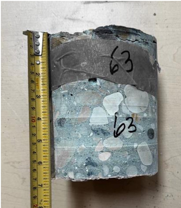
Sandstone PI, EBL ++ , Core 63 (Concrete Thk 165mm)
